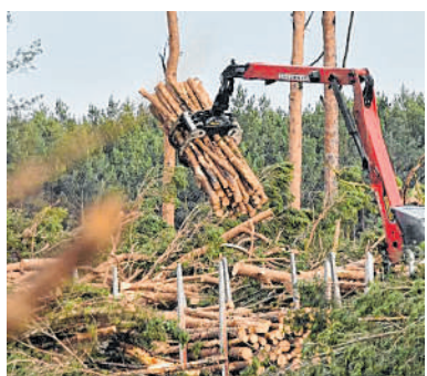
Die Rodungsarbeiten auf dem Gelände für das Tesla-Werk gehen weiter. BILD: DPA
