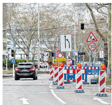
Wohl bis März bleibt die Baustelle auf der Theodor-Heuss-Anlage. BILD: TRÖSTER
